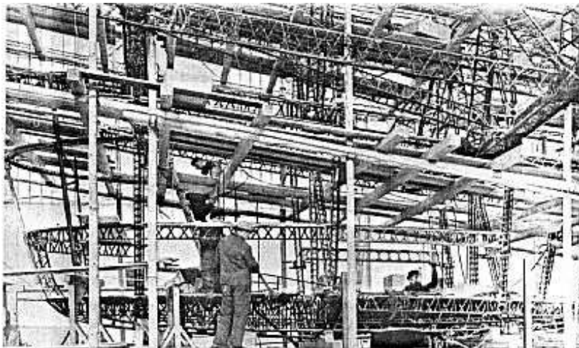
Az LZ129 vezetőgondolája építés közben. Megfigyelhető a gondola és a hajótest könnyűfém váza.
