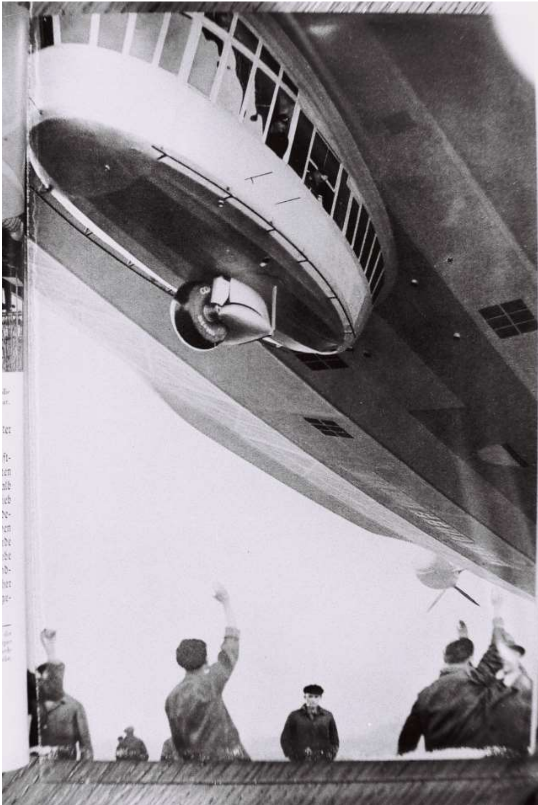
Az LZ129 vezetőgondolája. Éppen startol a léghajó. Felismerhető az áramvonalas kialakítás, a tartórudak, és a leszállókerék. A gondola fölött, a hajótestben lévő ablakok láthatók, éppúgy, mint a felső utasfedélzethez tartozó kitüremkedés, és egy gépgondola négyszárnyas propellerrel.
